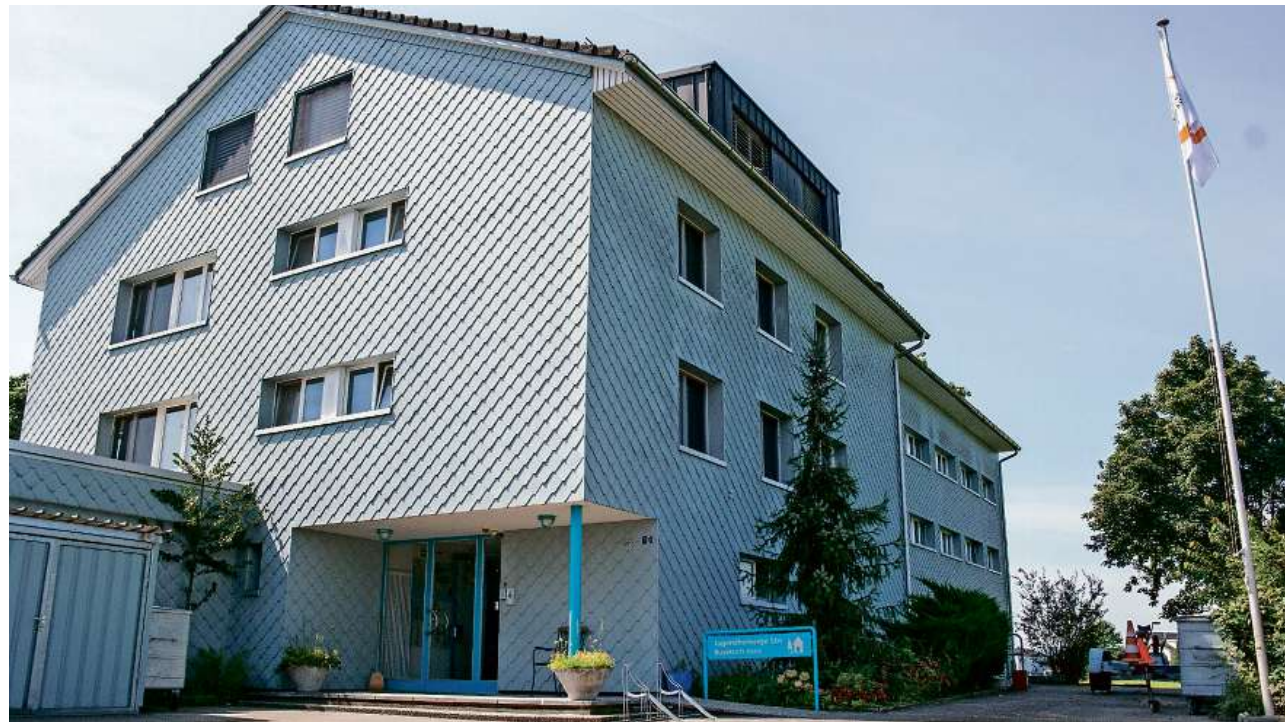
Aus der Zeit gefallen: Die Jugis in Busskirch soll endlich saniert werden.
